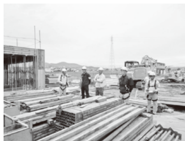
保育施設工事 パト風景
