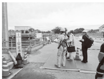
汚泥棟工事 パト風景
