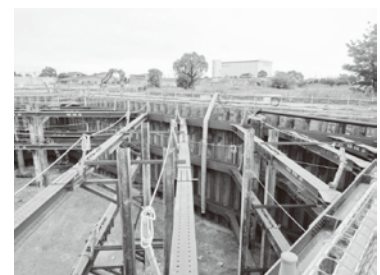
汚泥棟工事 送風機による換気
