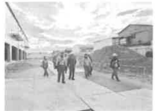
③流通倉庫新築工事
