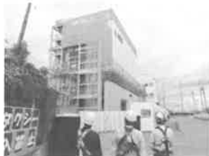
②化学工場新築工事
