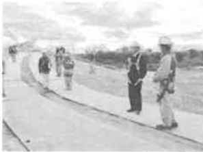
①新愛岐大橋工事
